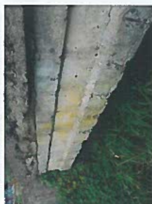
Detail ľavku krajného nosníku rozlítení NK na pravej strane mostu
