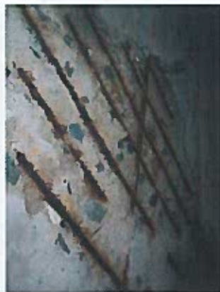
Obrázková výztaž v podhledu monolitické železobetonové desky
