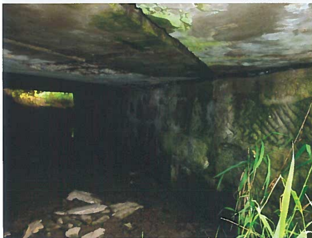
Most ev. č. 26834-2 přes náhon v Zákupích
