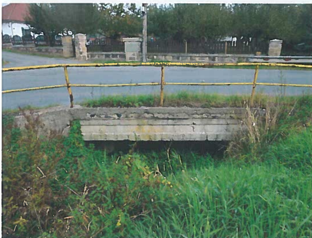
Most ev. č. 26834-2 přes náhon v Zákupech
