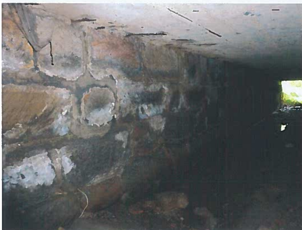
Most ev. č. 26834-2 přes náhon v Zákupech
