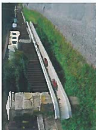
Aerické zvidňko na ľavé strane mostu
