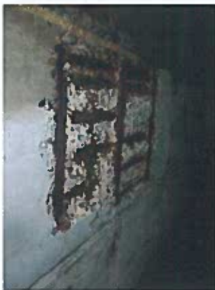
Obrázková výztaž v podhledu nosníku rozlišení NK na pravé straně mostu
